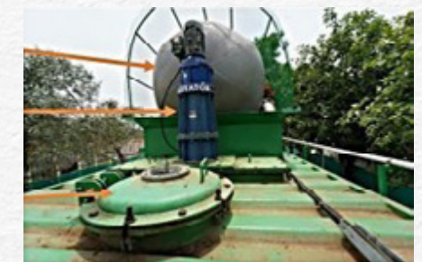
Figura 2.7. Bolsa para el almacenamiento de biogás junto con el agitador conectado al biodigestor
